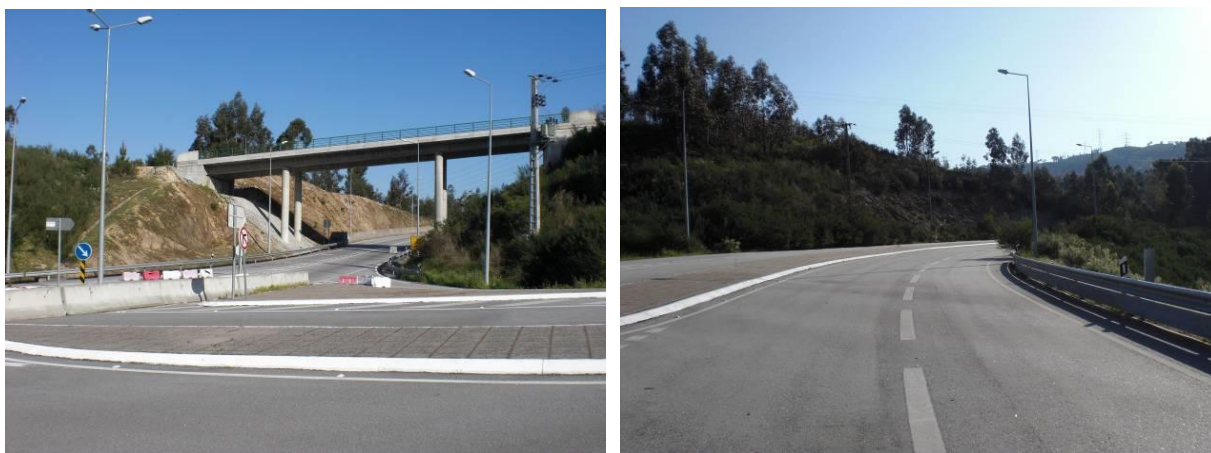
Figura 5.1 - Ligação no início da intervenção (Entroncamento com a Variante à EN 321-1)
